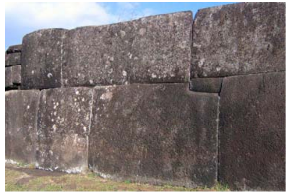
Ahu Vinapu – frappante Ähnlichkeit mit den grossartigen Steinmetzarbeiten der Inkas bspw. in Cuzco. Auf der Osterinsel sind es jedoch nie ganze Blöcke, sondern nur relativ flache Platten, welche die Front der Ahus beschliessen. Die Qualität des Ahu Vinapu ist zudem einzigartig – die meisten der übrigen 270 Ahus sind aus weitaus unregelmässigeren und grober zugehauenen Platten zusammengefügt.
