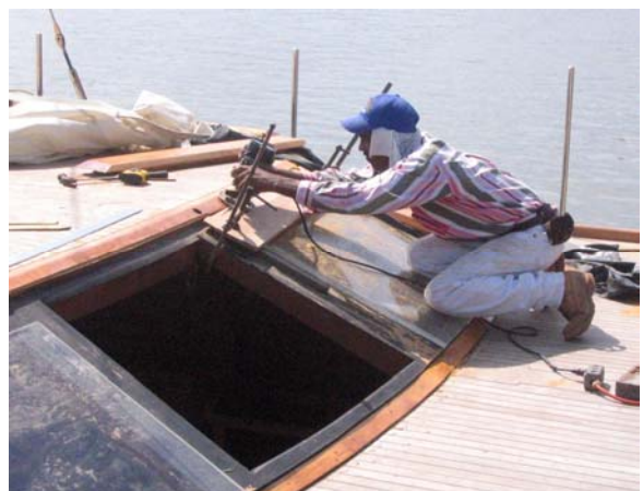
Juan beim Einpassen der Fenster mit der Oberfräse
