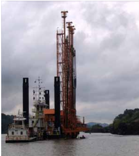
Schwimmende Bohrplattform zur Vorbereitung von Unterwasser-Sprengungen
