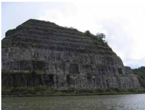
Felsdurchstich im Gaillard Cut
