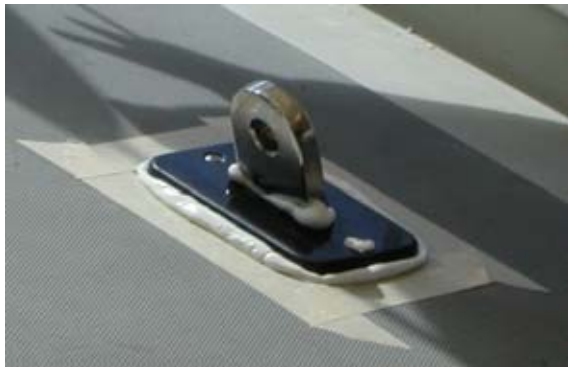
Erneuter Aus- und Wiedereinbau unserer Immer noch nicht dichten Rüstelsen mit nun definitiv abgeänderten Deckplatten
