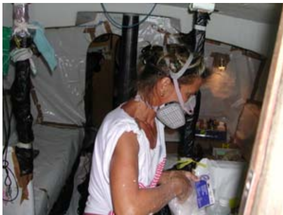
...und hier vor der letzten Schicht mit 2-K-Polyurethanfarbe
