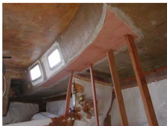
Einpassen und Einkleben von Sperrholz, nachher Überlaminiierung mit mehreren Schichten Glasfasermatte und Polyester. Auf der nächsten Seite ist das Resultat zu sehen.
