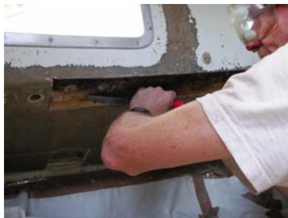
Ausstemmen von Hand – die Verhältnisse lassen ein Arbeiten mit Maschine kaum zu
