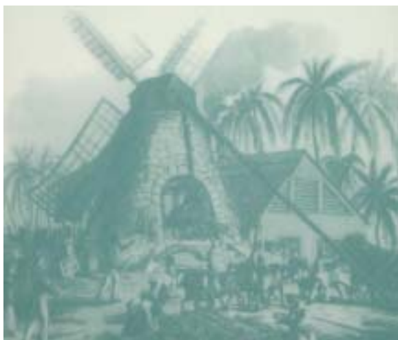
Annaberg in zeitgenössischen Darstellungen. Nebst Zucker wurden aus den Rückständen als Nebenprodukt auch Immer Rum produziert. Der Antrieb mit teuren Windmühlen lohnte sich nur in den grössten Plantagen mit genügend Zuckerrohrmachschub. Die meisten pressten die Zuckerrohrstengel mittels von Eseln angetriebenen Mühlen aus.
