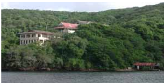
Die 3 separat liegenden Nonnenhäuser an der Westseite
